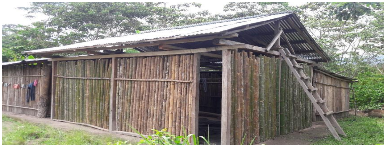
Fotografía N° 2. Construcción rústica con “marona” en el centro poblado de Bella Selva, (Moyobamba)
